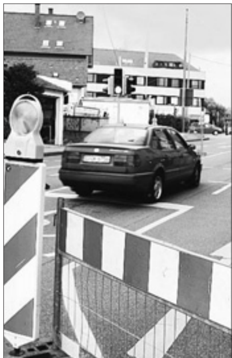
An der Ecke Rembrandtstraße/Vaihinger Straße ist eine Fahrspur wegen des Neubaus einer Kunstgalerie gesperrt. Foto: Kai Müller
