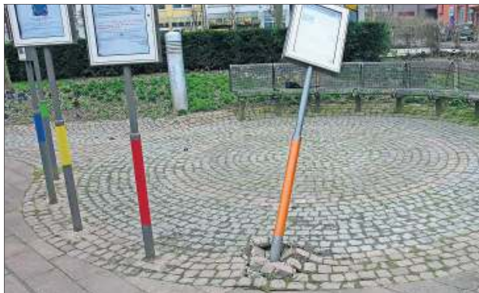
Der Schaukasten ist offenbar mit viel Kraft aus der Verankerung gerüttelt worden. Foto: privat
